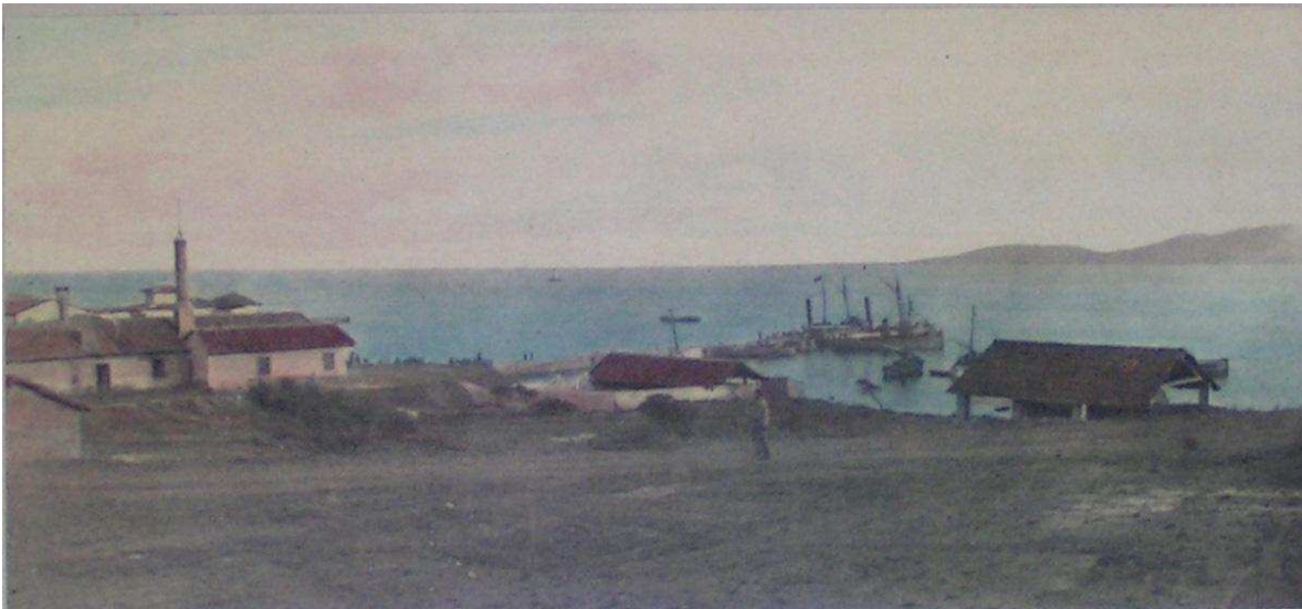
Cala reale. Veduta della lavanderia e dell'approdo. 1916 (Archivio Centrale dello Stato)
