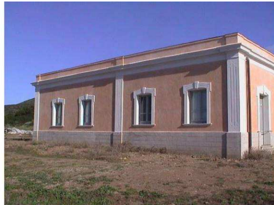
L'ex laboratorio batteriologico prima e dopo l'ultimo restauro (Archivio Ente Parco)
