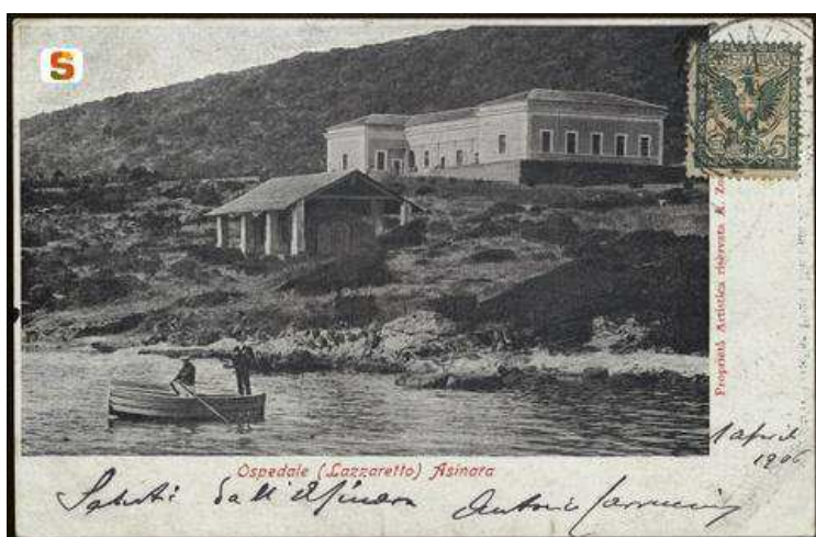
L'ospedale in una cartolina spedita nel 1906 (da Sardegna digital library). La baracca porticata è l'edificio di servizio dell'ospedale di isolamento, adattato nel 1916 ad alloggio ufficiali e oggi non più esistente
