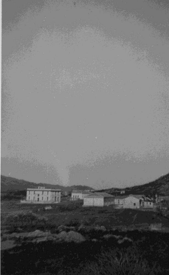
Edifici ristrutturati nel "paesello" alla fine degli anni '50 (AEP)
