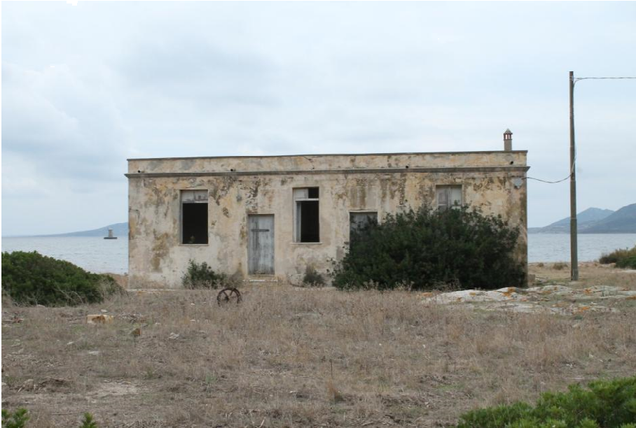
Stato attuale della centrale elettrica (foto A. Pisanu)
