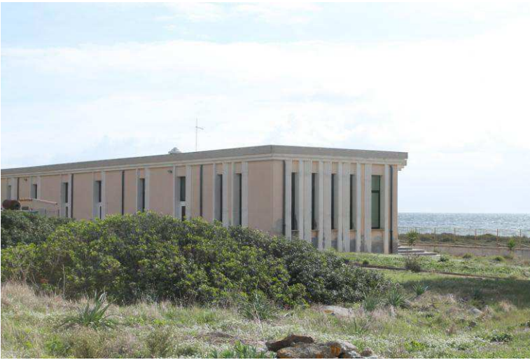
Stato attuale dell'edificio adibito a mensa dei Carabinieri (foto A. Pisanu)
