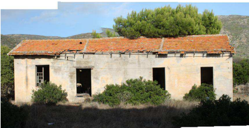
Stato attuale del magazzino di servizio alla nuova direzione sanitaria (foto A. Pisanu).
