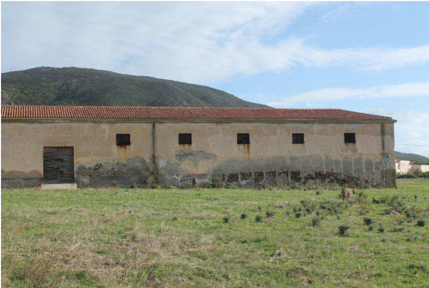
Stato attuale del magazzino officine e stalle (foto A. Pisanu)
