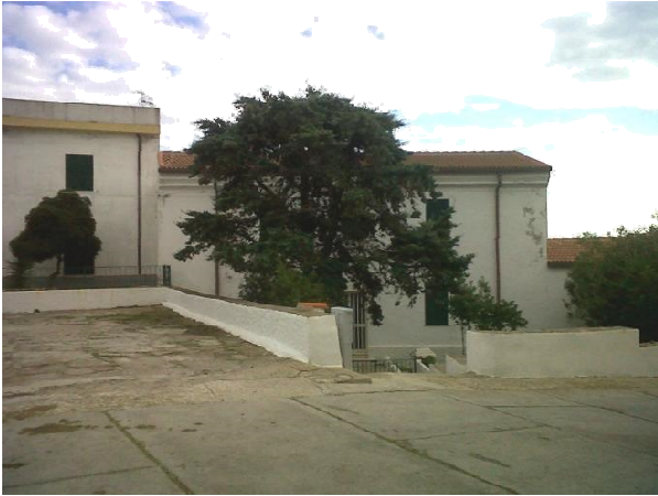
Il fabbricato 22/B
