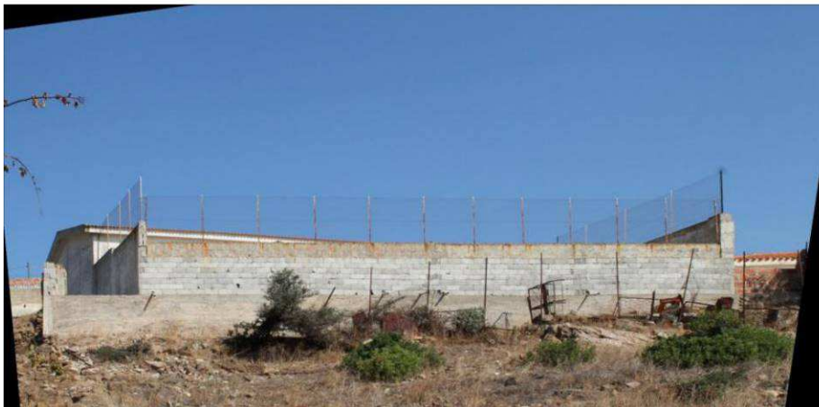
Stato attuale dell'isolamento, fronte e retro con cortile per l'ora d'aria
