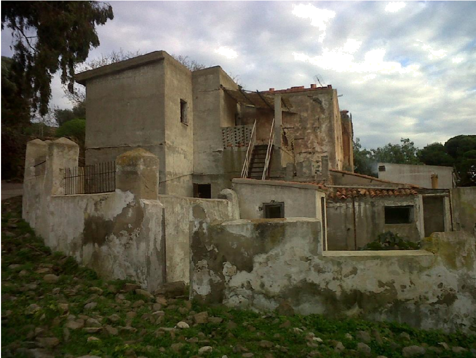
Fabbricato ovest dell'isolato 17/A, probabile alloggio del segretario
