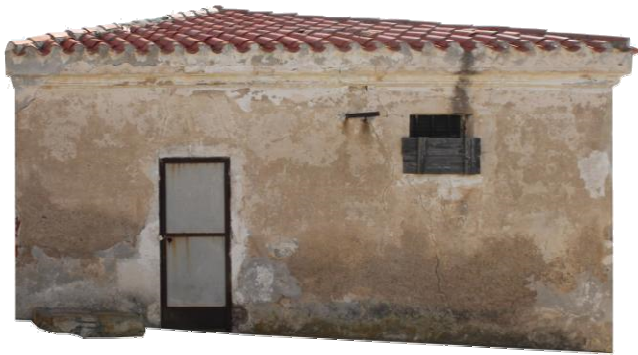
Stato attuale del mattatoio, prospetti sud e est
