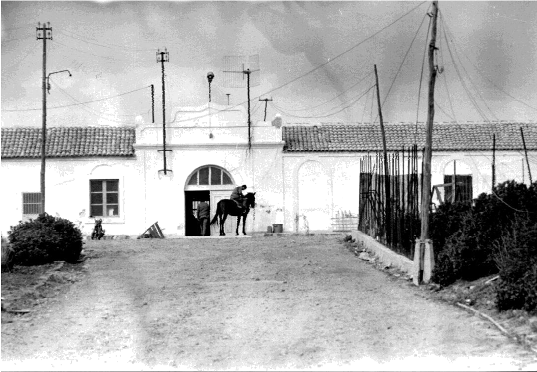
La facciata originaria della Diramazione centrale (Archivio del Parco)
