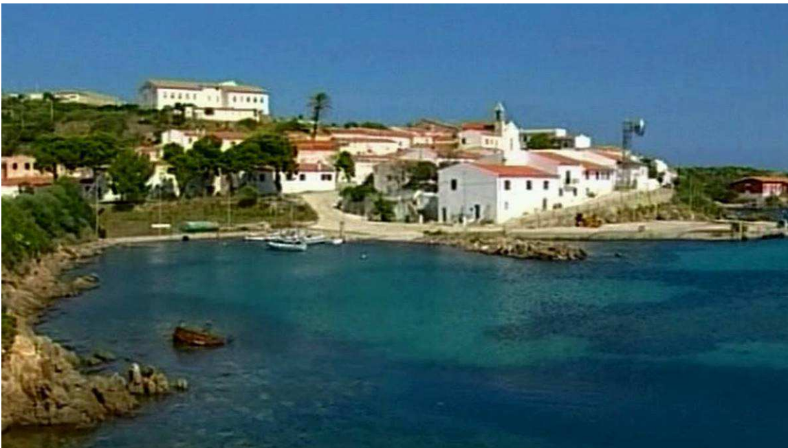
In questa fotografia antecedente all'ultima ristrutturazione la caserma degli agenti ha il tetto a due falde (Archivio del Parco)
