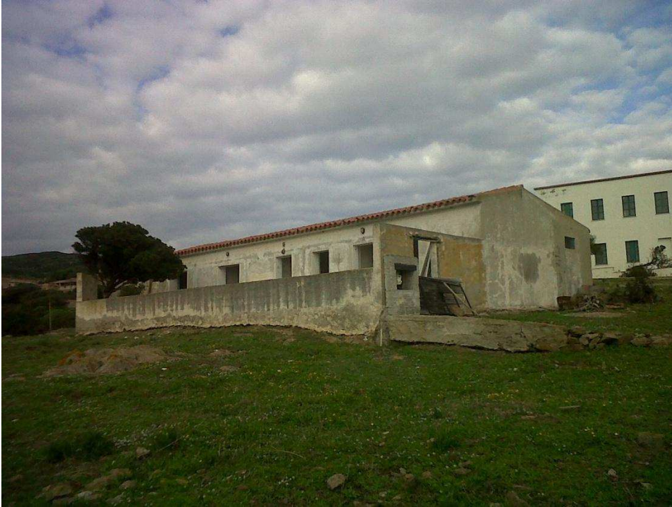
La casermetta degli agenti scapoli e, alle spalle, la nuova caserma oggi adibita a foresteria.
