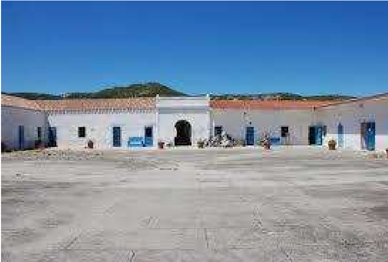
fabbricati della ex diramazione centrale e il cortile interno dopo l'ultimo restauro
