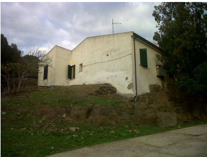
Edificio n. 16. Alloggio “marina”.
